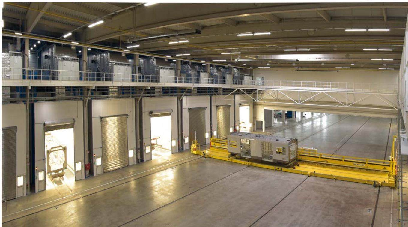
Kompletní lakovna skeletů ALSTOM Česká Lípa
