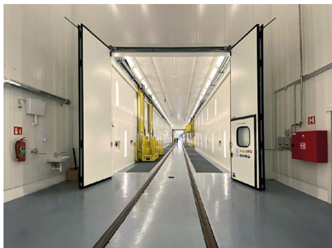
Celkový pohled do 120 m dlouhé lakovny
