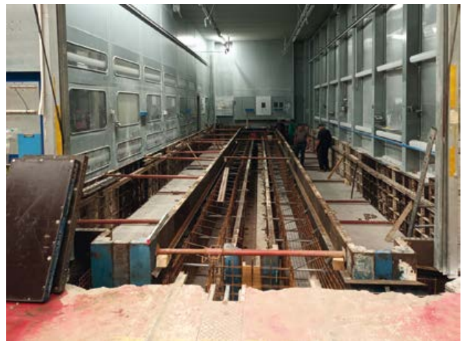
Příprava podlahy v kabině broušení
