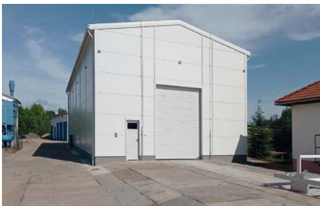
Lakovací hala ve venkovním provedení na lakování železničních sloupů
