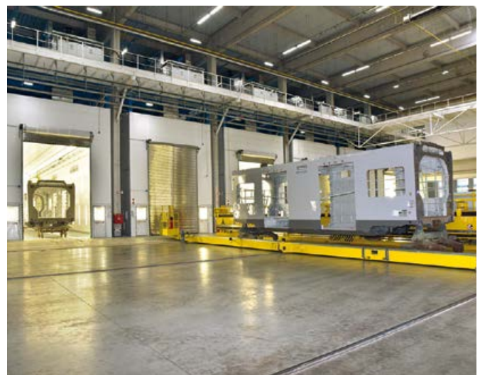
Kolejová přesuvna, ALSTOM Česká Lípa
