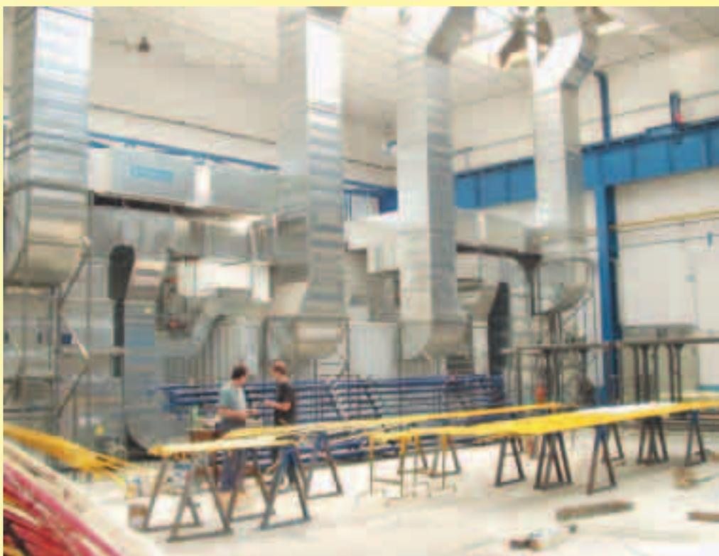
Vzduchotechnika je kompletována systémem záchytu plyných znečišťujících látek na aktivním uhlí.
