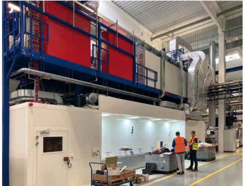
Dokončování montáže před předáním
