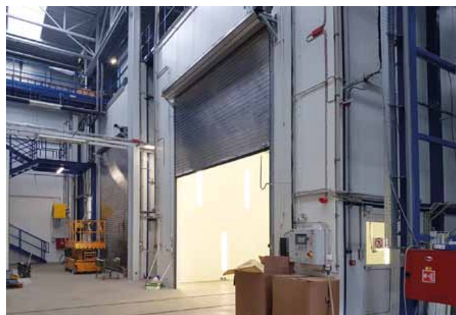
Dokončování montáže před předáním
