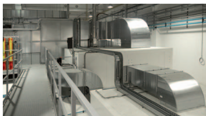
Vzduchotechnické jednotky umístěné na plošině
