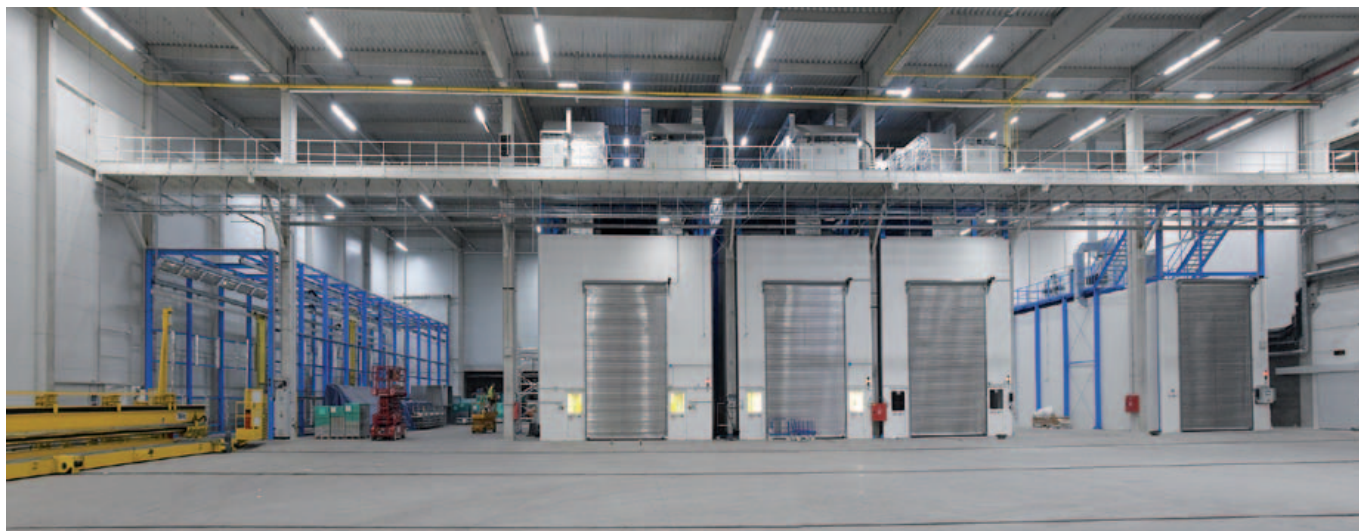
Celkový pohled na lakovnu
