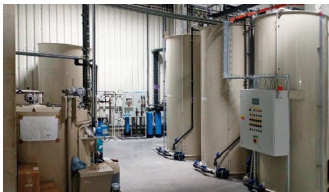
Pohled na vodní hospodářství
