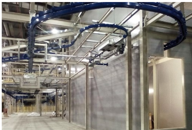
Průběh montáže - dopravní systém
