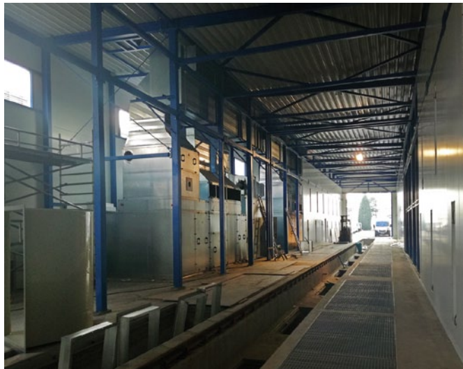
Průběh montáže ve firmě Českomoravská železniční opravna, s.r.o.
