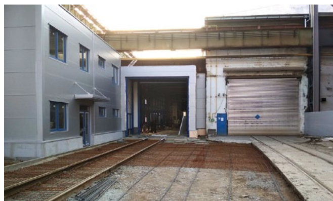
Průběh montáže - pohled na halu z venku
