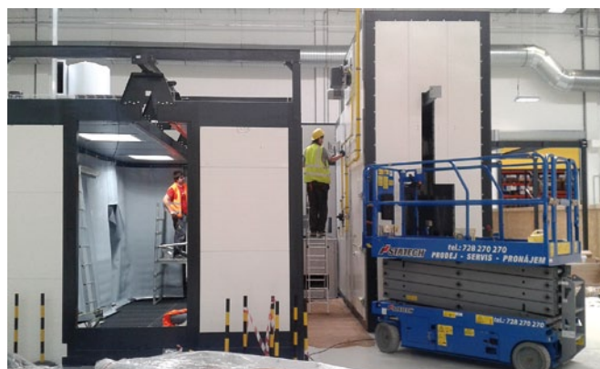
Montáž tryskací kabiny a sušárny FT Plzeň
