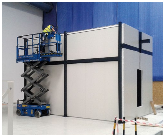
Průběh realizace odmašťovací kabiny
