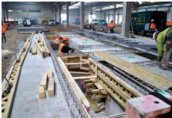
Průběh stavebních prací
