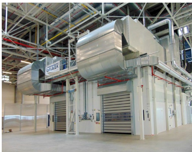
Lakovačí kabiny se vzduchotechnikou
