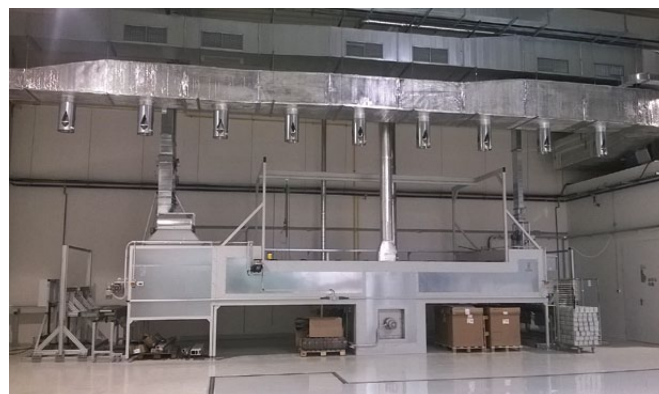
Průjezdni vytvrzovací pec, Elster s.r.o., Stará Turá
