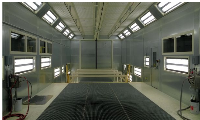
Vnitřek lakovacích kabin
